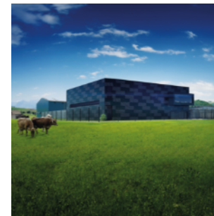
Rechenzentrum SAK Gais (CH)
